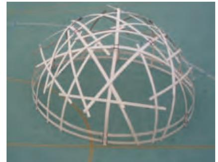
78 Emmanuel Heringer ist Zimmerer und Flechtwerkgestalter. Mit den Erfahrungen aus beiden Handwerksberufen entwickelte er einen Iglubausatz aus Birkenperrholzstreifen. Das Flechten ist eine der ältesten Techniken, sich einen Raum zu schaffen. Der wechselseitige Druck und die Verformbarkeit der biegsamen Materialien ergeben dabei einen stabilen Verbund.
